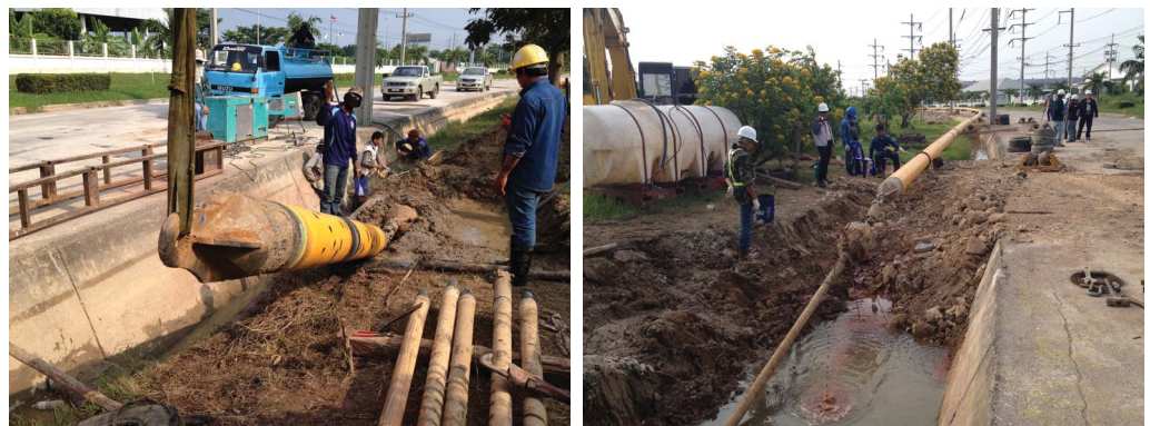
การขุดเจาะแบบไม่เปิดหน้าดิน (HDD)
