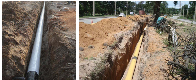
การขุดเจาะแบบเปิดหน้าดิน (Open cut)
