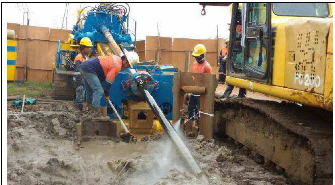
การเจาะดิ่งท้อลอด (HDD)
